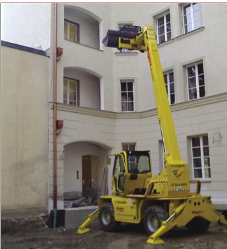
Gekonnt wird der Teleskopstapler in Position gebracht.
