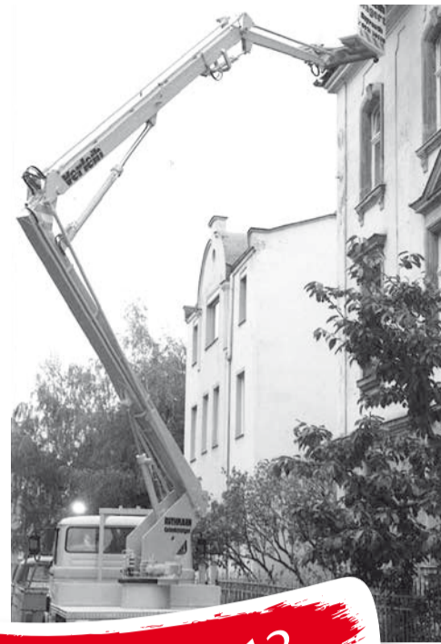
1983 – Die erste LKW-Arbeitsbühne im Einsatz
